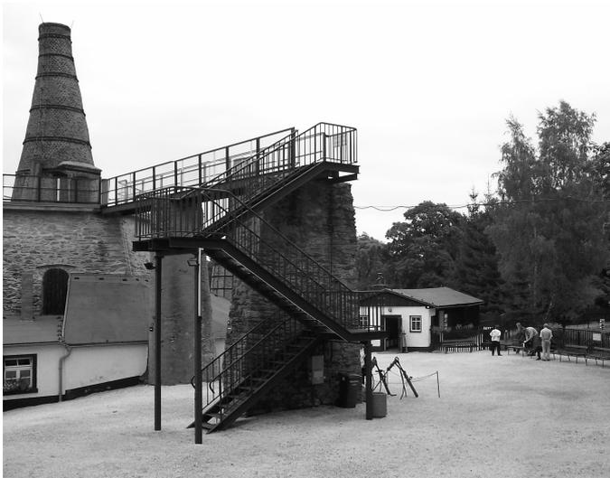
Abbildung: Brennoven zur Herstellung von Branntkalk
